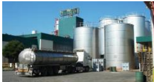
Refinería Andaluza, Alcolea (Córdoba)
